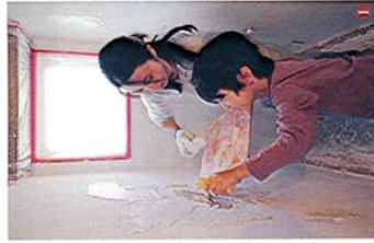
1 トイレの壁は水野さんご一家だけで塗った場所。次男の知風くんも、一生懸命お手伝い。2 外壁、内装とも、スイスの天然漆喰「カルクワカール」の塗り廻り。トイレでも換気扇や洗面台を塗装してくれる。ドアの扉やバーホルダーは、水野さんの手作り。
