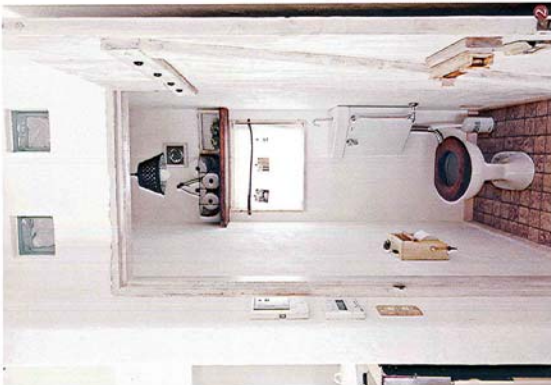
1 トイレの壁は水野さんご一家だけで塗った場所。次男の知風くんも、一生懸命お手伝い。2 外壁、内装とも、スイスの天然漆喰「カルクワカール」の塗り廻り。トイレでも換気扇や洗面台を塗装してくれる。ドアの扉やバーホルダーは、水野さんの手作り。
